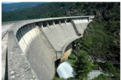
Barrage de Sénéchas sur le Gardon d'Alès, département du Gard.
